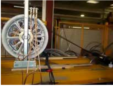
Poules avec système de mise à la terre conformes aux standards internationaux
