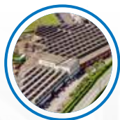
TESMEC S.p.A. Usine de production Sirone (IT)
