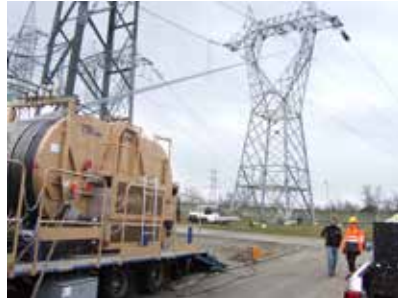
Tireuse-freineuse jumelée avec cabestans de 2 mètres de Ø, secteurs en acier interchangeable et circuits hydrauliques redondants
